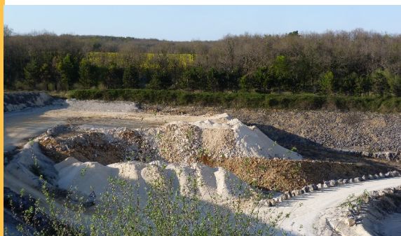
▲ La zone en cours de remblayage
