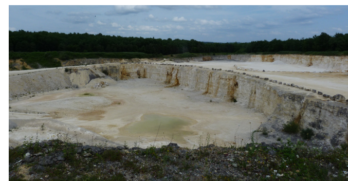
▲ Les carrières de Tinteillac et de Bois de Halas
