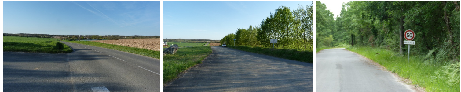
▲ La RD 99 au droit du site avec l'accès à la carrière et la piste enrobée menant à la carrière : au niveau du raccordement à la RD 99 et dans le Bois de Halas
