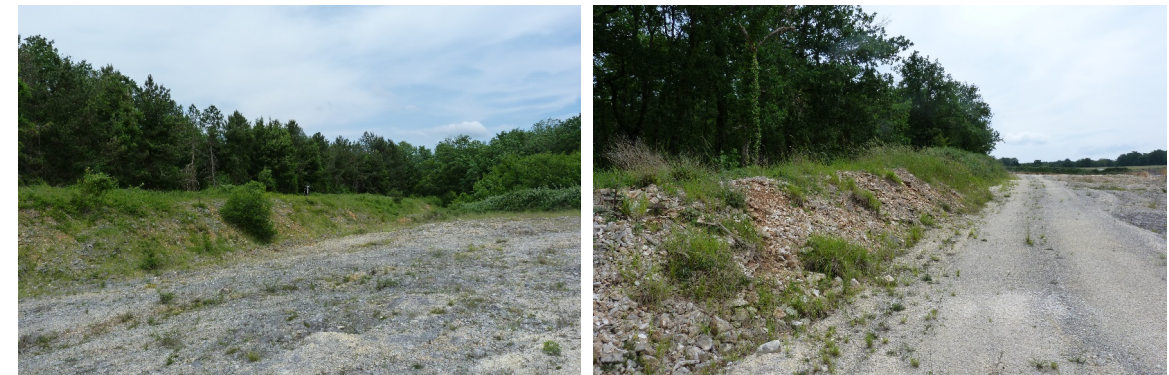
▲ La zone décapée et le merlon périphérique
