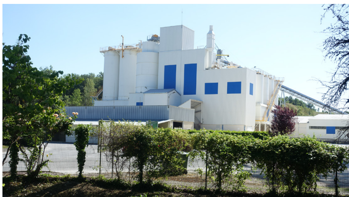
▲ L'usine de Bourg-des-Maisons
